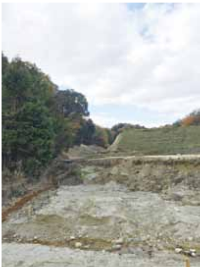
昨年秋の台風21号により破堤した水口町の大谷新池
