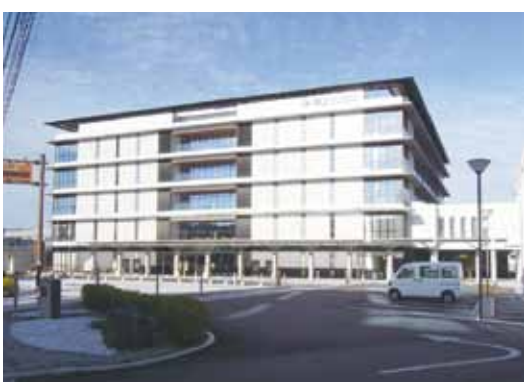
働き方改革が望まれる市役所本庁舎
