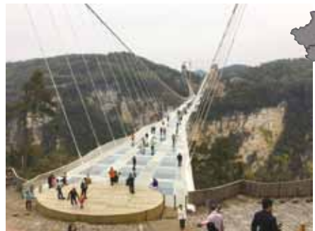
張家界市のガラスの吊り橋
