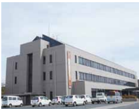
改修予定の甲南第一地域市民センター
