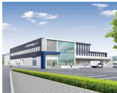
2020年4月操業予定の(仮称)西部学校給食センター
