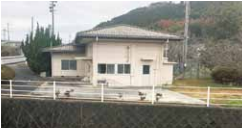
盛土による対策が予定されている保育園用地
