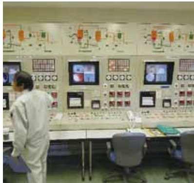
燃えるゴミ中央操作室
