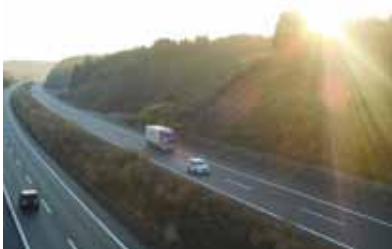
今後6車線化が進む新名神高速道路
