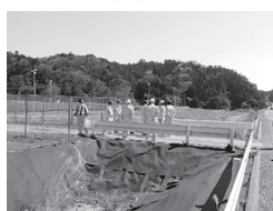
甲賀山1C取付道路付近
