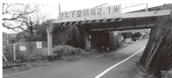
降雨時にはいつも冠水するJR高架下(貴生川第三団地)
