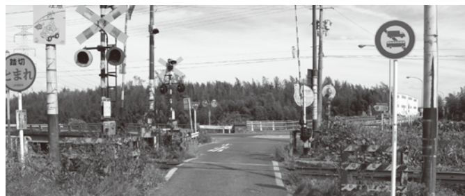
JR協議が必要な危険踏切
