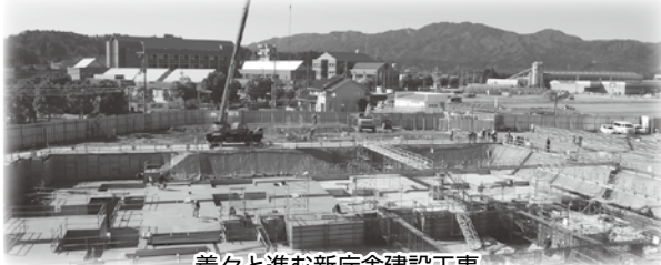
着々と進む新庁舎建設工事
