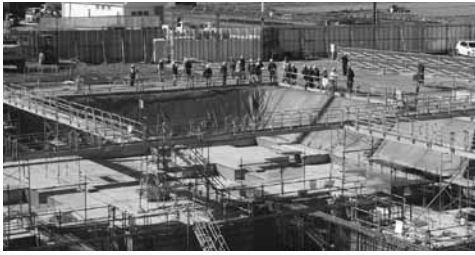
建設中の新庁舎
