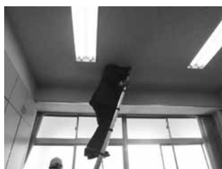
是正工事の確認
