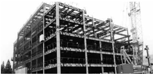
合併特例債を有効活用し建設が進む新庁舎
