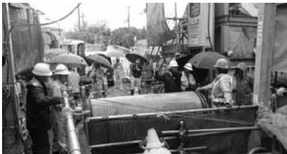
勅旨・長野地区 第一污水幹線整備工事
