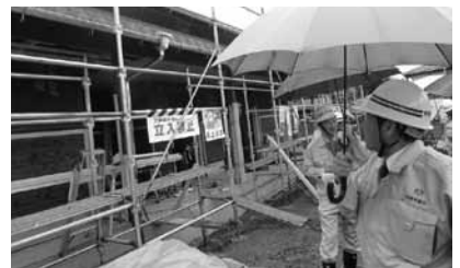
雲井駅前観光トイレ建設工事
