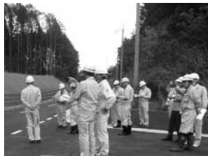
市道漆谷中山谷線災害防除工事(甲賀町神保地先)
