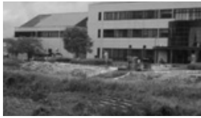
改修・利活用がのぞまれる庁舎
