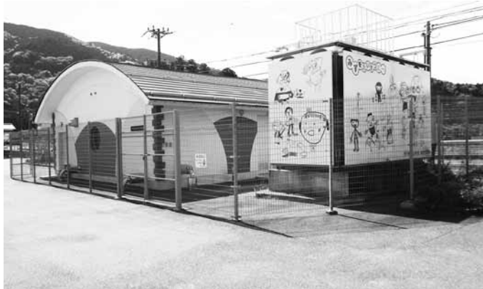
鮎河第2水源池（外観）
