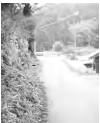
黒滝の危険箇所
