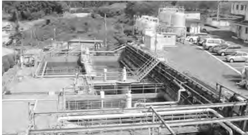
老朽化により建築予定の水処理施設
