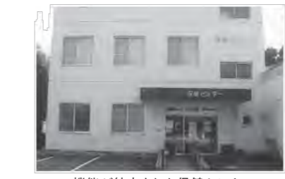
機能が縮小された保健センター
