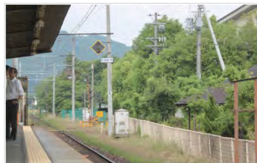
近江鐵道 (水口城南駅周辺) JR貴生川駅から市本庁舎、文化芸術施設、ショッピングセンターへ利用が多い。
