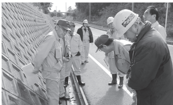
漆谷中山谷線法面調査
