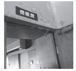
老朽化が進む水口庁舎
