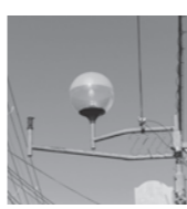
1灯欠落の2灯型老朽街路灯
