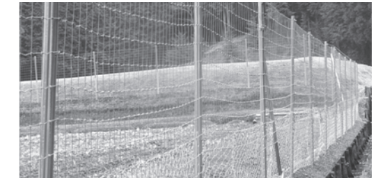
市内で設置が進む鳥獣侵入防止柵
