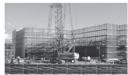
現在の工事風景
