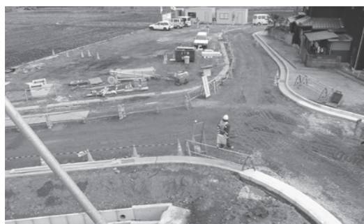
大野交差点改良工事
