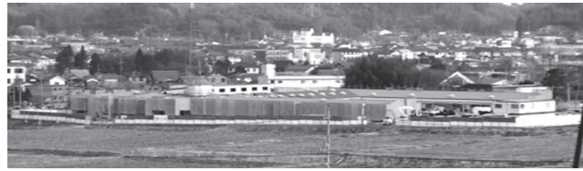
工事が進む認定こども園
