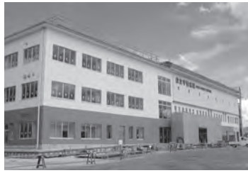
正面玄関付近
