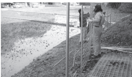
獣害防護柵設置作業
