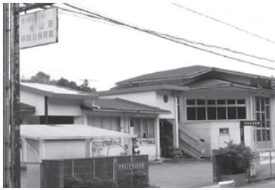
老朽化が進む園舎
