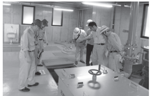
施設内部を現地調査
