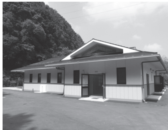
完成した朝宮の集落排水施設
