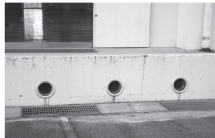
体育館通気口
