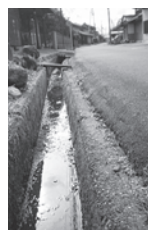
改修を急ぐ片山今宿の側溝
