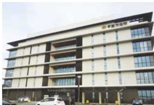
総工費68億円の水口本庁舎 その内46億円が有利な合併特例債を活用
