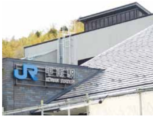
完成間近の甲南駅
