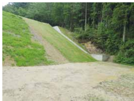
災害復旧工事が完了した永谷池
