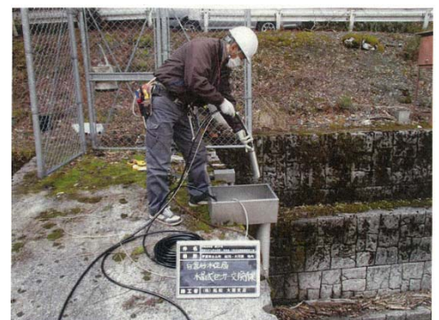
白倉谷水位局施設更新工事 (水晶式センサー設置作業)
