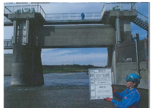
水口頭首工ゲート点検業務委託
