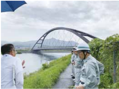
令和元年5月26日に開通した瀬田川令和大橋
