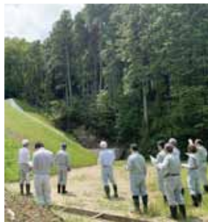
復旧工事が完了した永谷池
