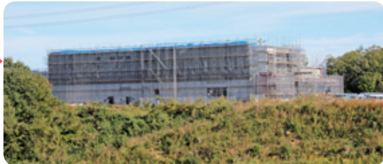
▲建設が進む(仮)西部学校給食センター(水口町山上地先)
