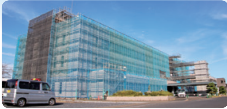
▲複数の施設の機能を併せ持つ複合施設として改修中の甲南第一地域市民センター
