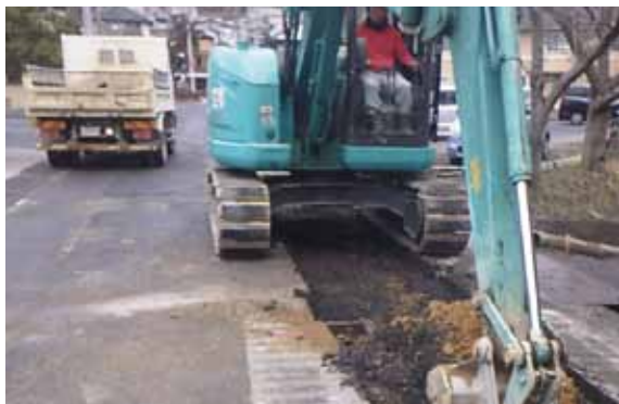
工事が進む信楽地域の公共下水道事業
