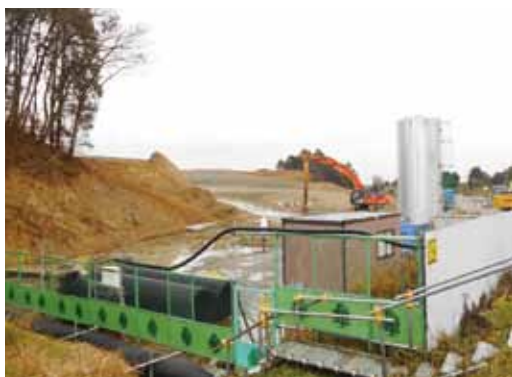
工事が進む甲賀北工業団地
