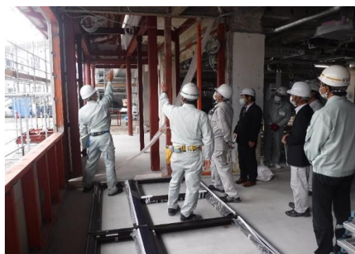
水口社会福祉センター改修工事
