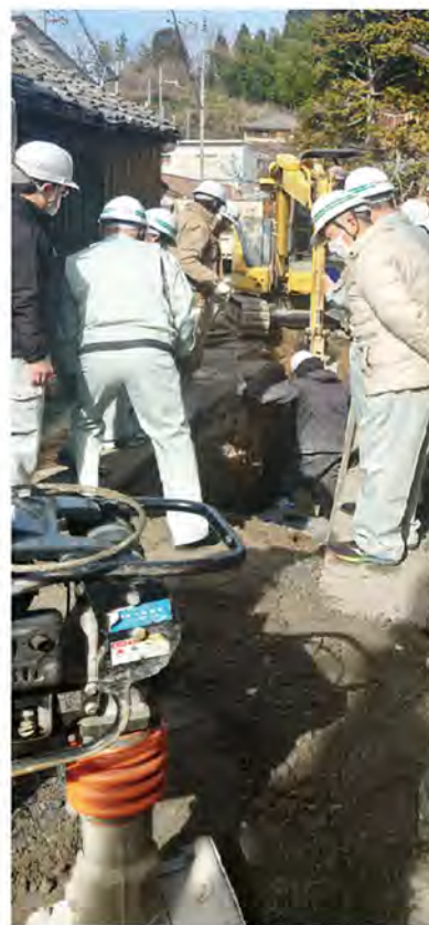
信楽町長野地区での管渠布設作業
