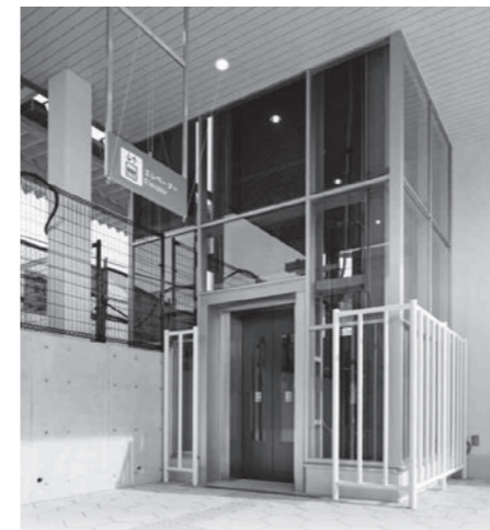
南北両側にエレベーターを設置
