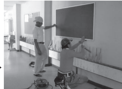
施設の修繕作業を行う皆さん(水口小学校)
