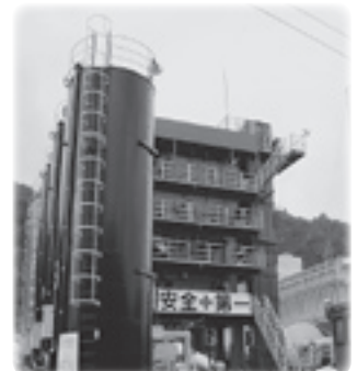
▲完成したアスファルトプラント
