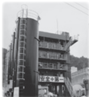
完成したアスファルトプラント
