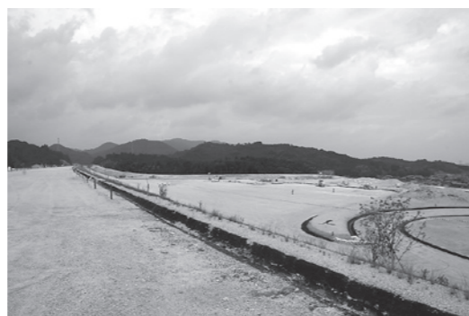
▶工事が進む甲南パーキングエリア
