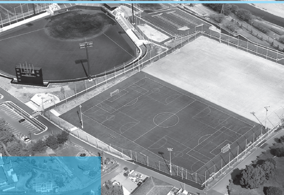
▶昨年完成した甲賀市民スタジアムと多目的グラウンド。甲賀市民スタジアムは9月15日（土）・16日（日）開催の日本スポーツマスターズ2007びわこ大会軟式野球の会場となる。
