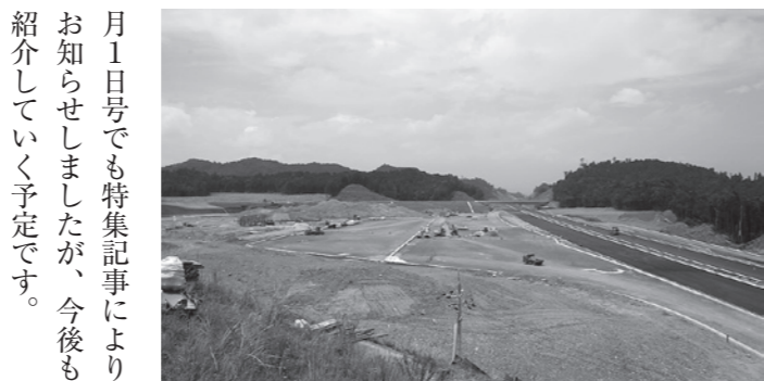
▶土山サービスエリアでは特産物の販売も予定されている
