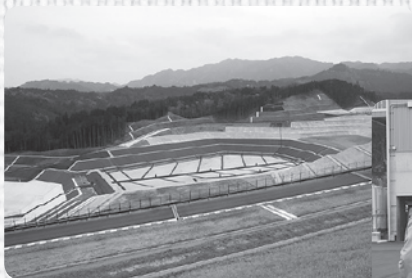
▼甲賀町神地先に整備されたクリーンセンター滋賀
