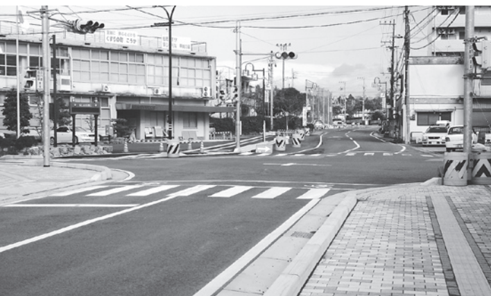
▲甲賀支所周辺の道路整備
