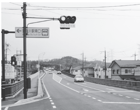
▲国道307号右折だまり
