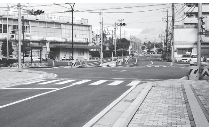
▲甲賀支所周辺の道路整備
