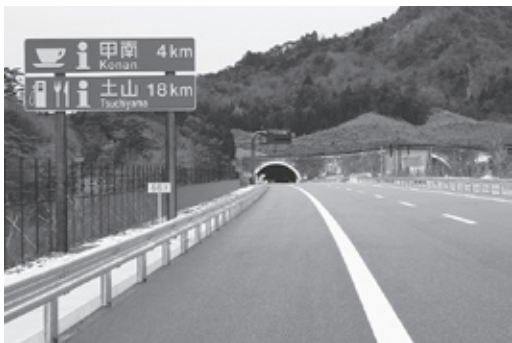
▲甲南トンネル西側
