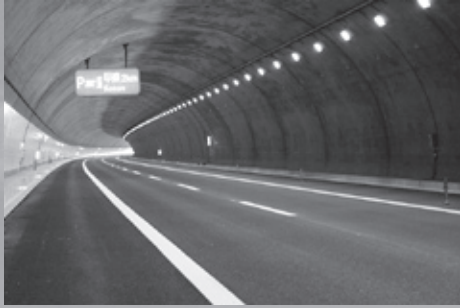
▲甲南トンネル
