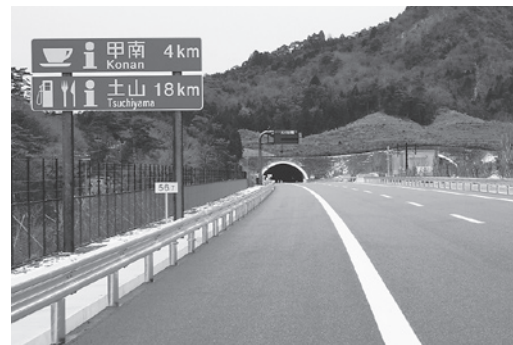
▲甲南トンネル西側
