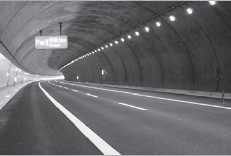
▲甲南トンネル
