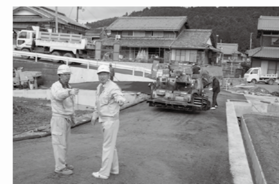
▲土山地域の工事現場
