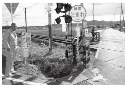
▲踏切現場とその状況を確認
