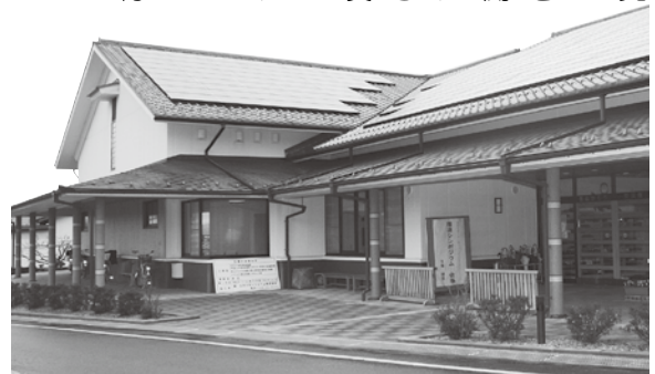
▲屋根にパネルが取り付けられた里山かむら交流館
