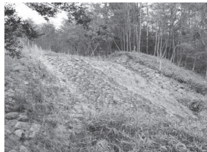
▲下山川砂防堰堤群
