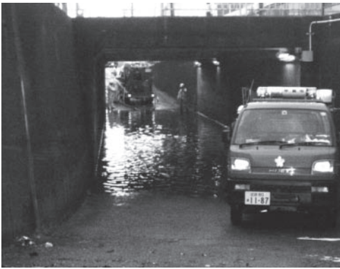
▲水口町名坂・国道アンダーの冠水状況(6月16日)
