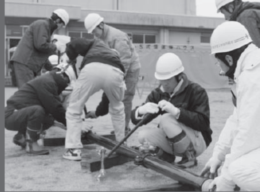
▼管工事協同組合による給水訓練
