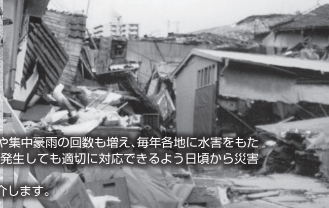
▼阪神・淡路大震災で倒壊した家屋
