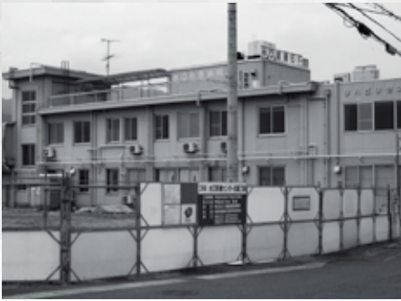
▲工事が始まった診療所棟
