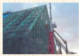
▲鉄骨納品後の建物外観
