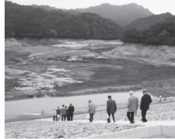
▲工事が終わった大原ダムを視察する関係者
