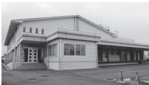
■貴生川小学校校舎改築事業(耐震化工事含む)
