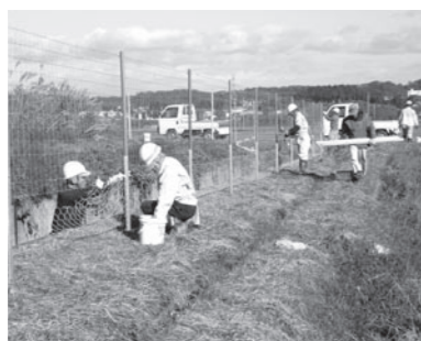
侵入防止柵設置の様子(水口町蟻峨)
