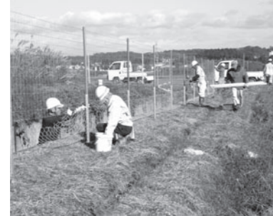
侵入防止柵設置の様子(水口町蟻峨)
