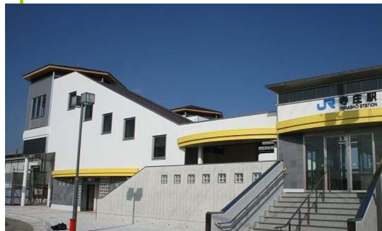
平成22年12月に完成した新しいJR寺庄駅
