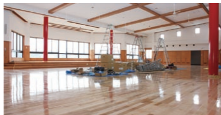
遊戯室(完了間近の仕上げ作業中)
