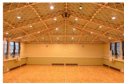
甲賀中央公園体育館の耐震補強
